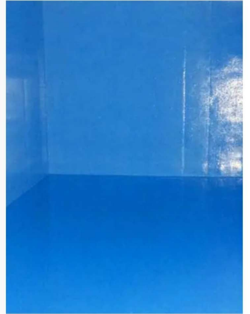
عزل خزانات المياه
